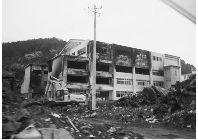
大槌町市街地（4月撮影） 火災があったことがわかる。
